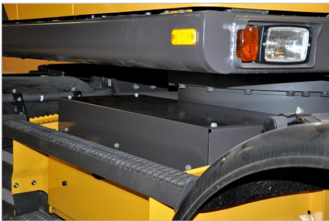
Skåp där bromssystemets ventiler finns placerade.
